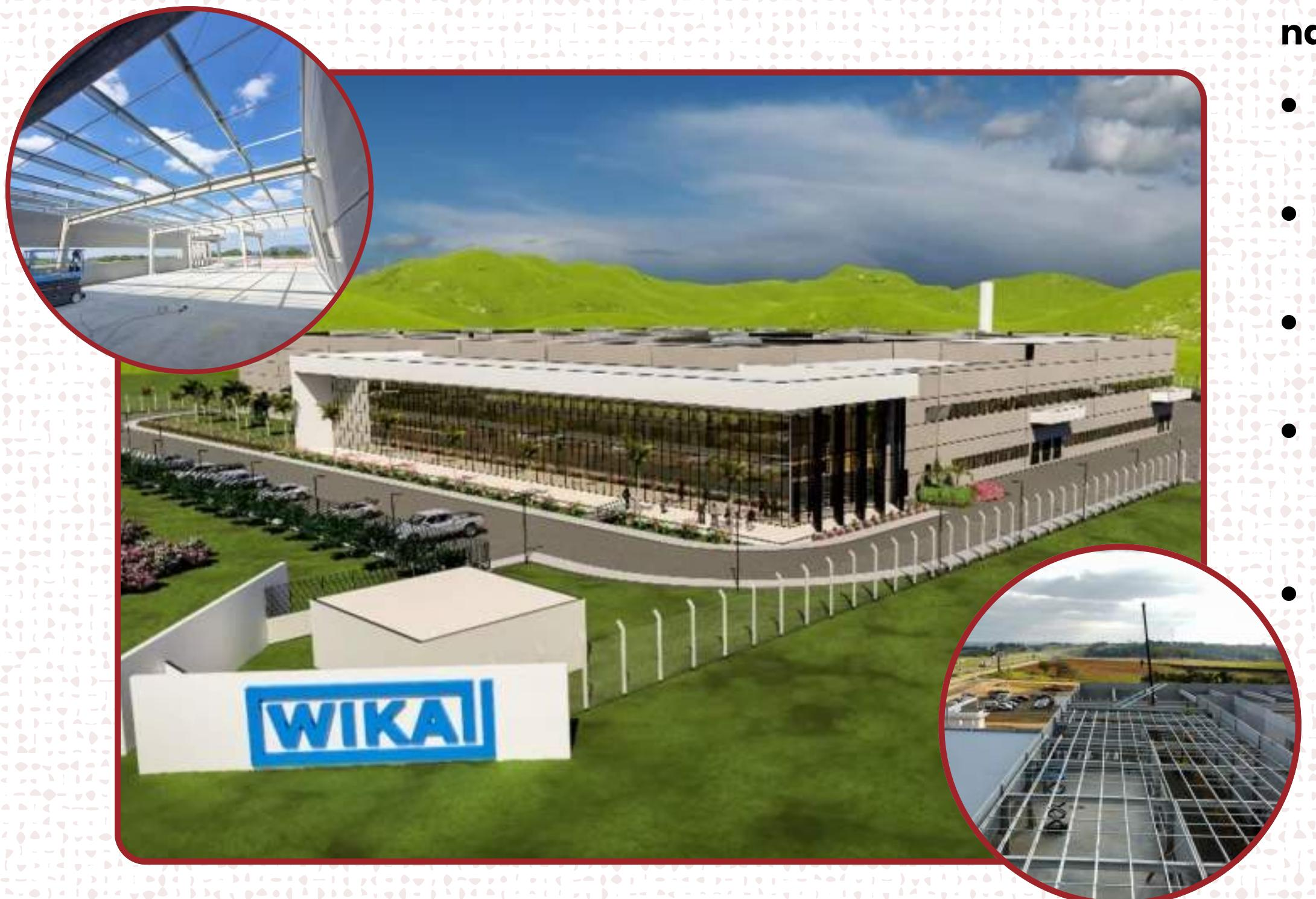
Nosso escopo dentro do projeto do novo complexo industrial da Wika abrange os serviços de **cobertura de galpões termoacústicos, estruturas metálicas para marquises, instalação de rufos e calhas, bem como a iluminação natural com os lanternins**
